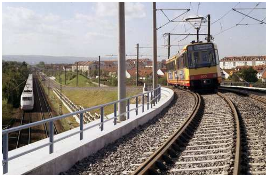
Abbildung 4.28: Beispiel für kleine Erhebung: Straßenbahnbrücke über die Rheintalbahn.
